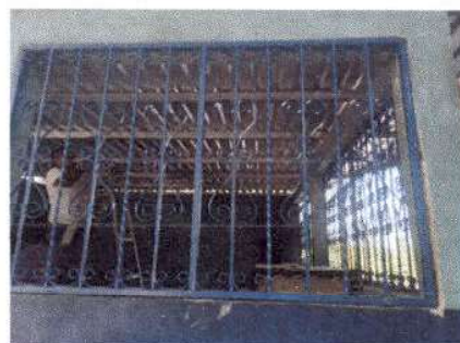
Foto 10: Fabricación e instalación de balcones de hierro en ventanas en cocina
