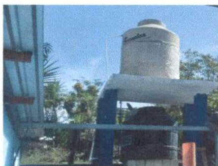
Foto 15: Sustitución de depósito de agua y sus accesorios
