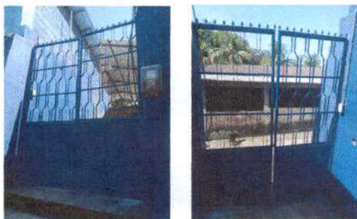
Foto 3: Mantenimiento a portón de metal de entrada principal en exterior e interior
