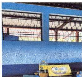
Foto 7: Pintura en muros interiores en aulas
