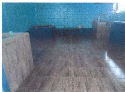
Foto 5: Sustitución de piso de cemento líquido por piso cerámico en cocina
