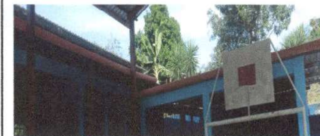
Foto 14: Sustitución de canal de PVC 3" en el establecimiento
