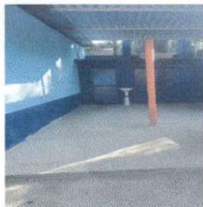
Foto 13: Reparación de planchas en losa de patio
