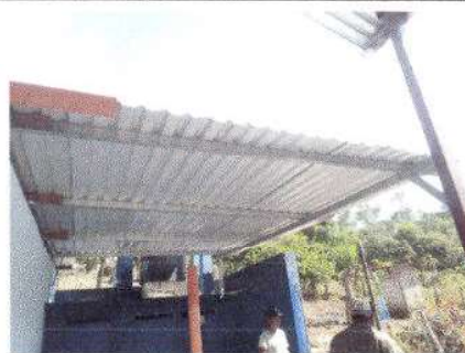
8: Sustitución de lámina por lámina aluzinc calibre 26 y sustitución de soporte de metal por soporte de metal en el área frente a baños.
