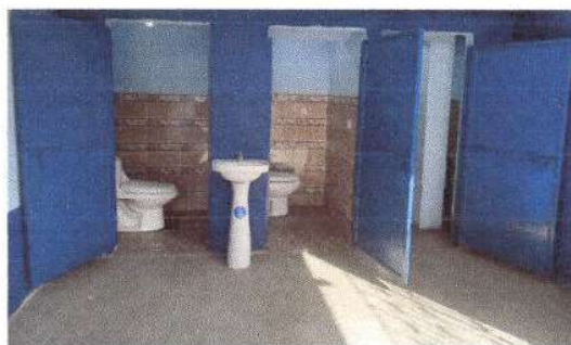
Foto 9: Sustitución de azulejo y piso cerámico en el área de baños
