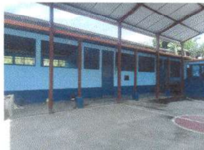
Foto 6: Pintura en muros exteriores en aulas
