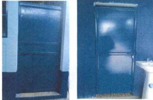
Foto 2: Mantenimiento a estructura en puertas de metal en el establecimiento.
